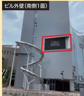
ビル外壁(南側1面)
