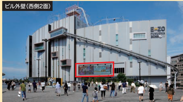
ビル外壁(西側2面)
